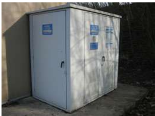
Poste compact PTC, équipée d'un transformateur sec imprégné.
